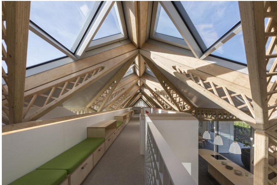
Figura 24: Estruturas da Clarabóia e Mezanino do Centro Maggie Manchester
