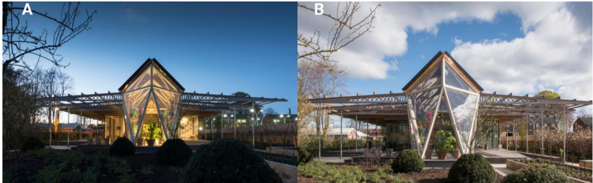
Figura 17: Vista frontal do Centro Maggie Manchester
