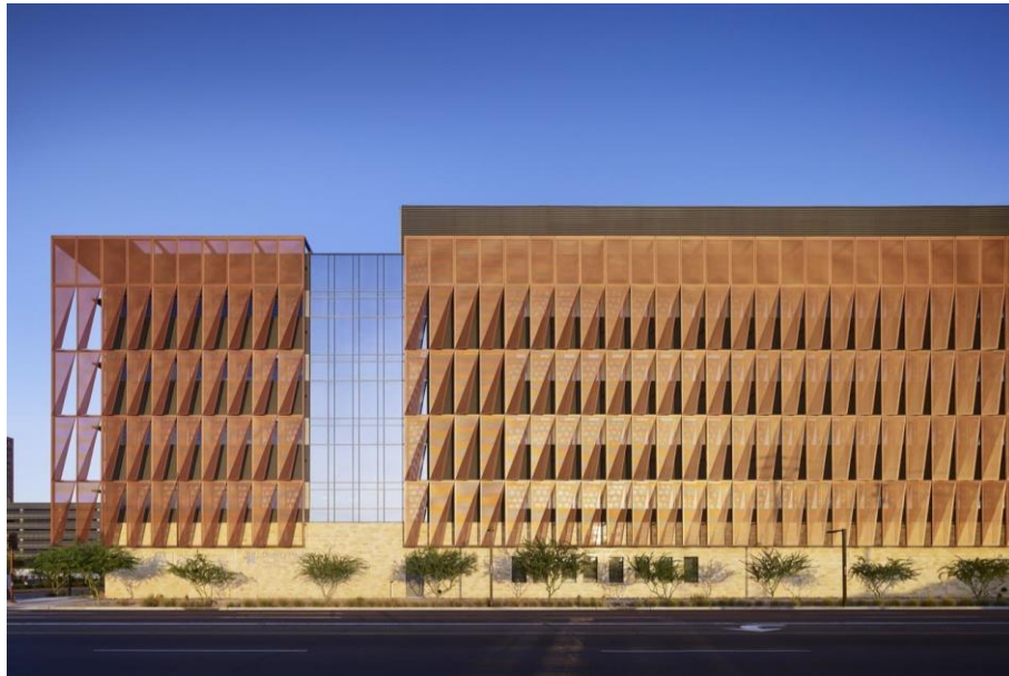
Figura 7: Fachada lateral do Centro do Câncer da Universidade do Arizona.
